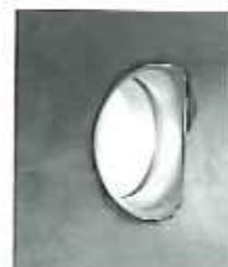
SUSブッシュ取付状況 (管内面)
