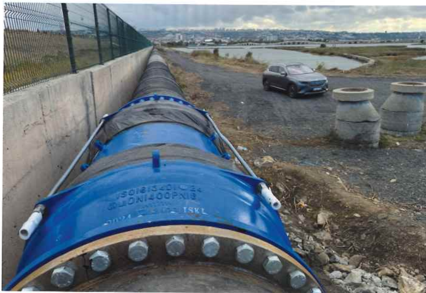
タイ・フレックス 呼び径1400ミリ トルコ・イスタンブール ボスポラス海峡
