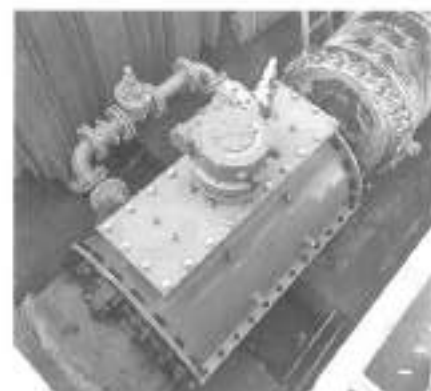
呼び径900設置状況
