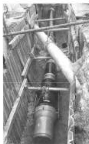
呼び径400設置状況
