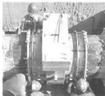
呼び径900mm本体取付状況
