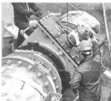
呼び径900mm穿孔作業状況
