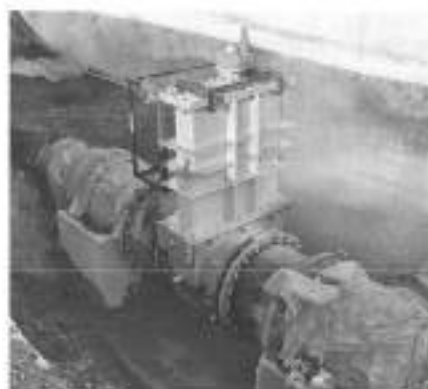
呼び径900mm設置状況
