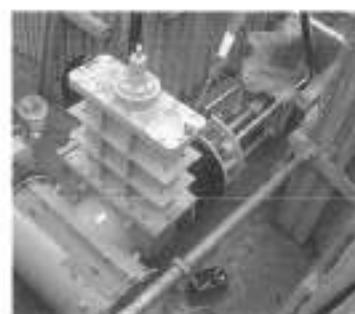
呼び径600×600設置状況
