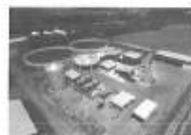
清水町美菱バイオガスプラント
