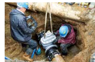
■仕切弁の取付
