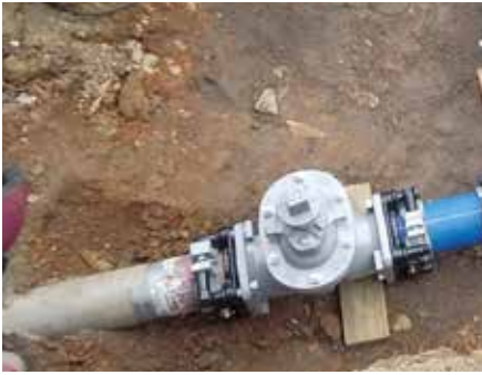
スッポンMソフト150 ステンレス鋼管×配水用ポリエチレン管(JIS外径)での使用
