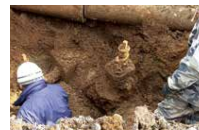
■既設バルブ掘削
