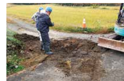
■既設バルブ交換箇所
