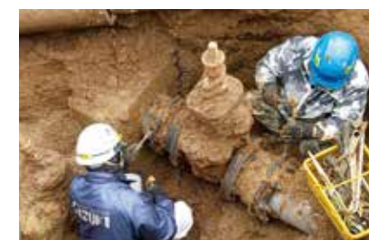
■既設バルブ取り外し
