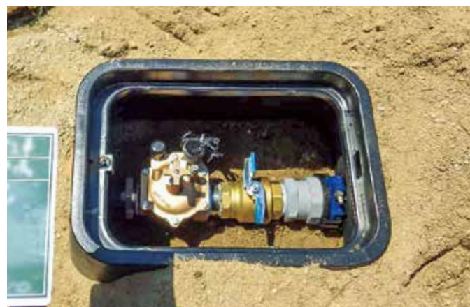
散水配管での使用
