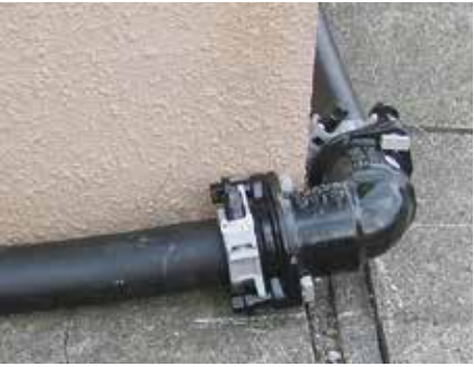
スッポンショートMVB75×90° 一般用ポリエチレン管(JIS外径)での使用
