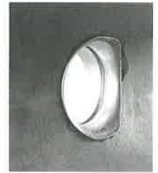
SUSブッシュ取付状況 (管内面)
