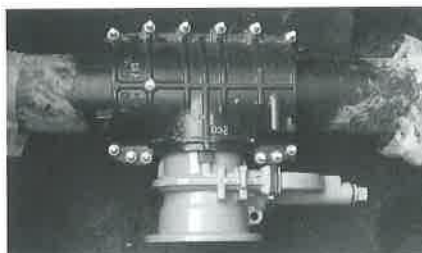
スマートバルブは水平方向にも設置可能
