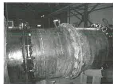
写真：呼び径900 水圧0.75MPa異常なし
