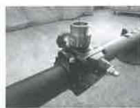
作業弁取付状態
