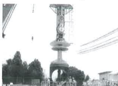
インサートパタフライ弁 取付作業
